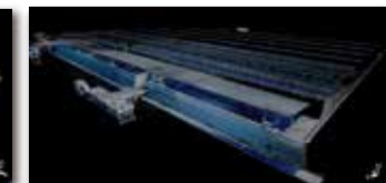
港湾工事/ソーラーパネル設置
