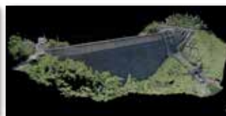
構造物メンテナンスの現況調査
