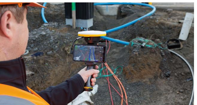
地下に埋設するケーブルなどのモデルをSiteVisionの画面に表示して『見える化』しています。どの場所にどの埋設物を設置するかなど、ビジュアルに確認することができます。
