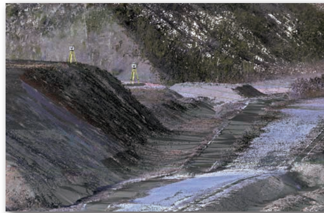
【ポイントクラウド】 Trimble SX10 と取得した点群を3D表示で確認
